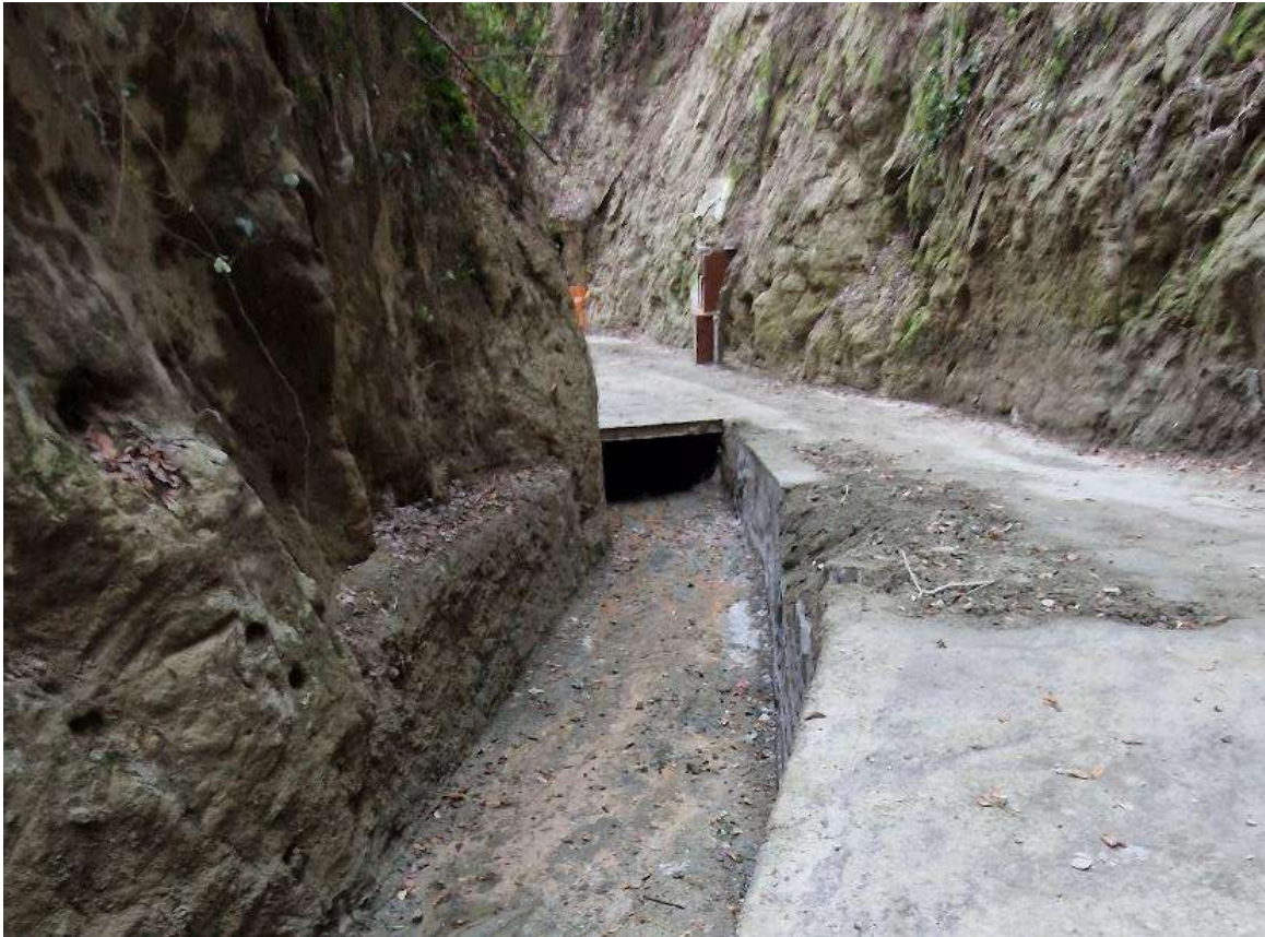
S_ 23_ F. Ponte in putrelle e tavelloni realizzato in corrispondenza dell'alveo per consentire in passato l'accesso alle terme
