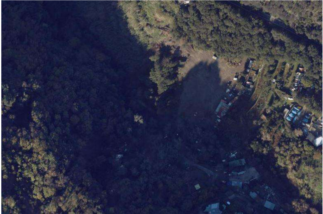
P_1_F. Piazzale realizzato con terreno di riporto in corrispondenza della zona sommitale della sponda in destra idraulica. Il terreno di riporto non presenta alcuna opera di contenimento e presenta importanti dislocazioni lungo il versante che determinano accumulo di materiale all'interno dell'alveo inficiandone l'officiosità. In aggiunta il piazzale risultante dal riporto del terreno ha modificato il sistema di raccolte delle acque in destra idraulica del Puzillo.
