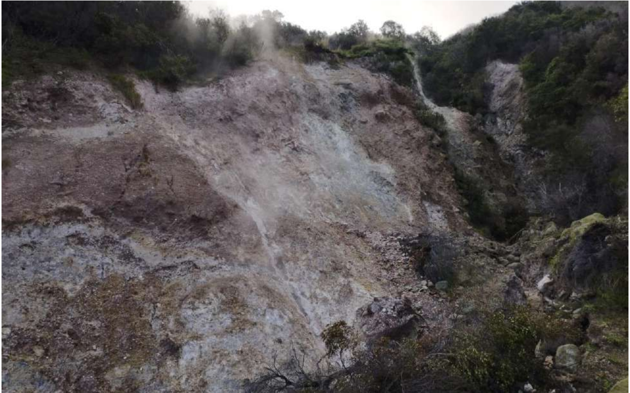
M_1_F. Pareti laterali soggette a scivolamenti superficiali, presenza di fonte Termale
