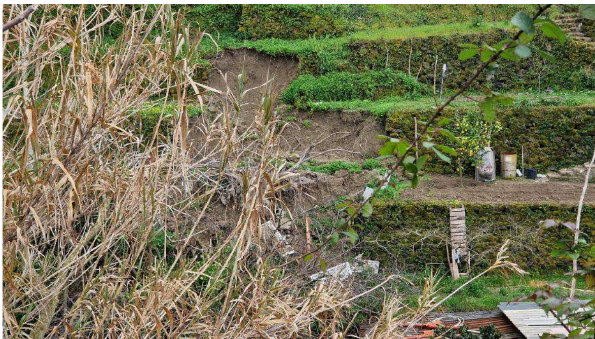
P_ 8_F. Scorrimenti superficiali dei versanti laterali terrazzati mediante muri a secco, parracine.
