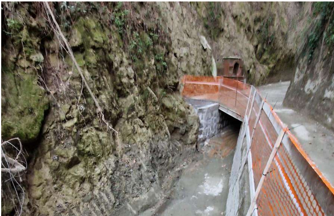
S_ 24_ F. Ponte in putrelle e tavelloni realizzato in corrispondenza dell'alveo per consentire in passato l'accesso alle
