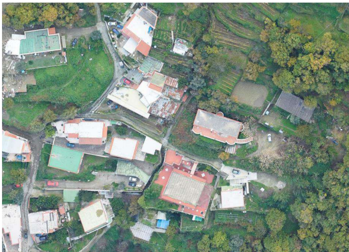
CU_15_F. Ortofoto che mostra l'attraversamento dell'alveo in una zona urbanizzata attraverso canale di raccolta successivo ad un tratto in cui l'alveo risulta trasformato in sede stradale
