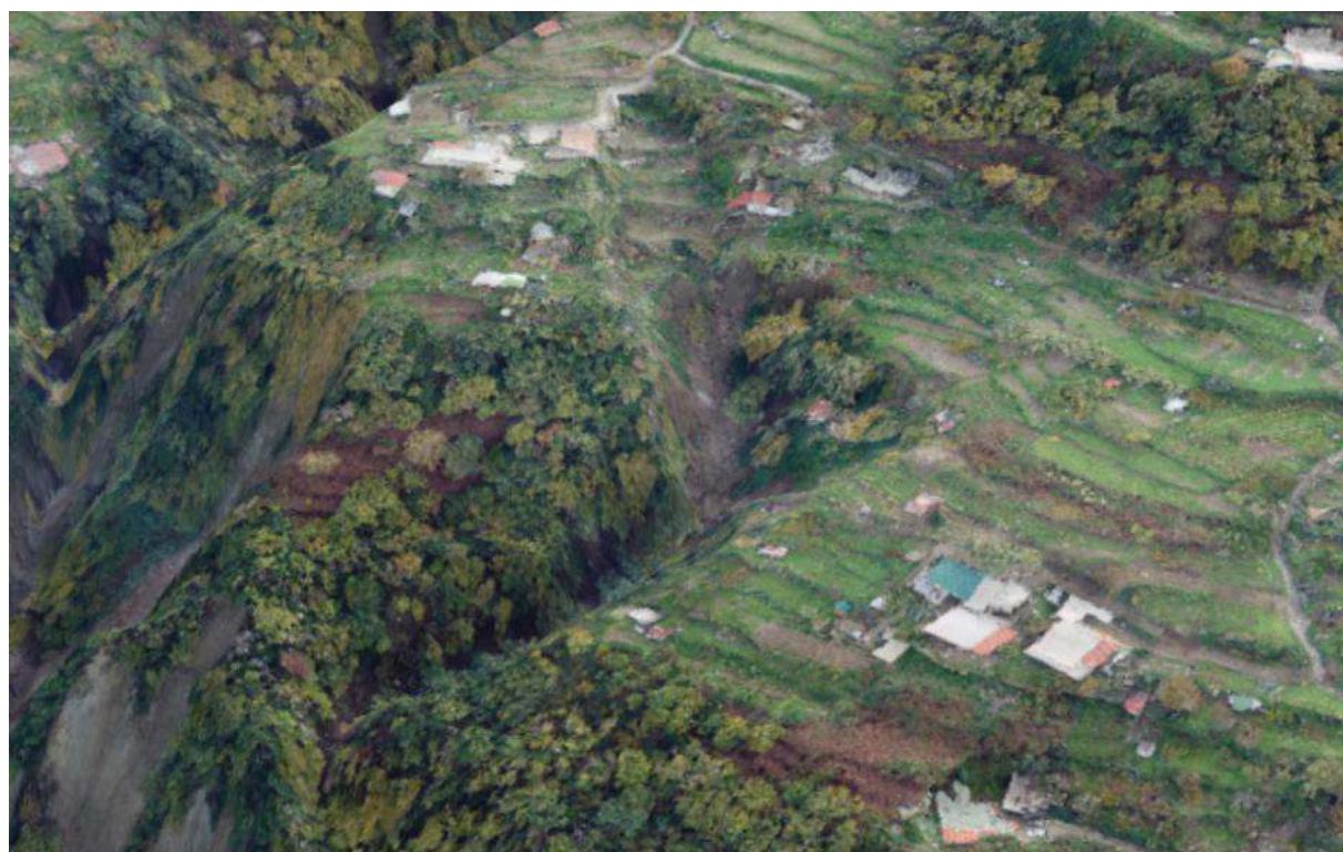
CA_3_F. Imbocco alveo Fasaniello dove è evidente un alveo già fortemente inciso.
