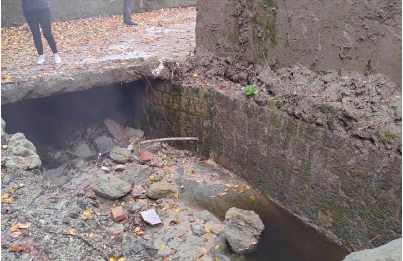
F_26_F. Sezione di imbocco dell'alveo tombato. Sezione parzialmente ostruita da blocchi lapidei sul fondo
