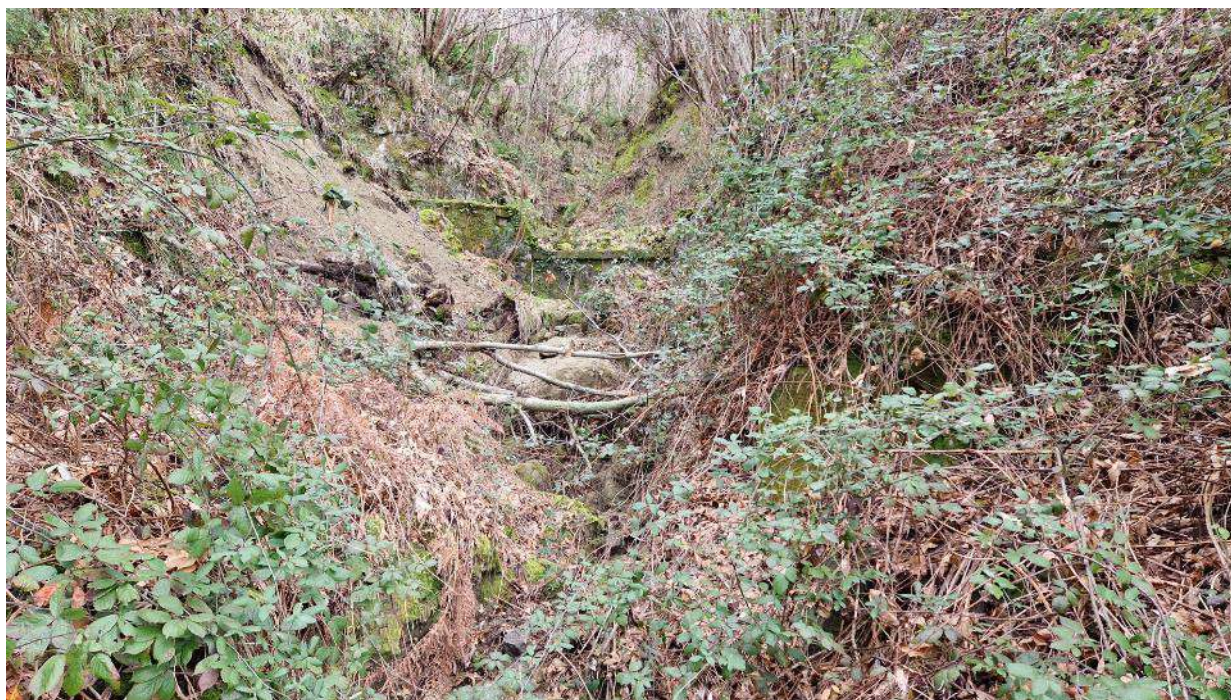
CU_14_F. Briglia anni 40 completamente ricoperta di materiale depositatosi negli anni
