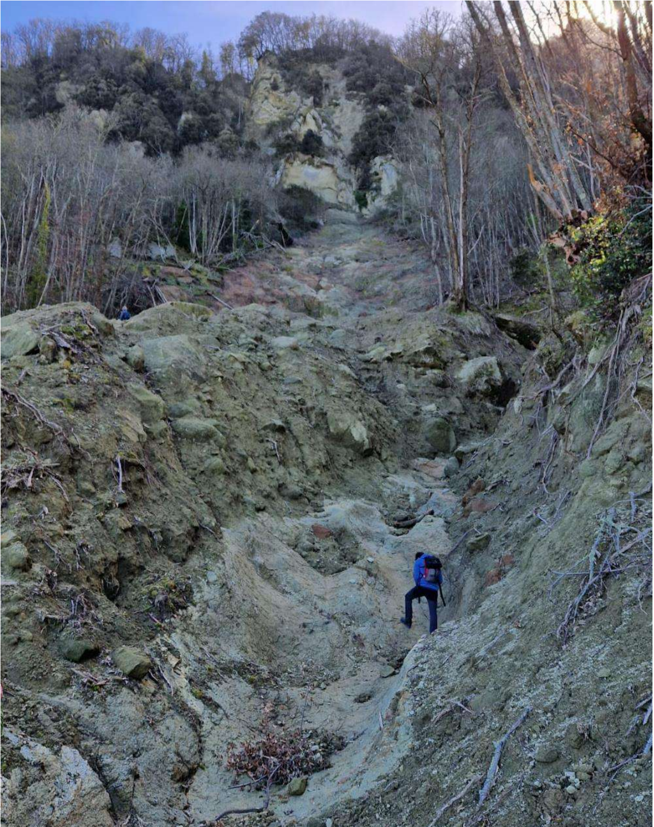
CE_ 2. Alveo eroso dall'evento franoso del 2020. Depositi di fango solidificato lungo il letto della frana
