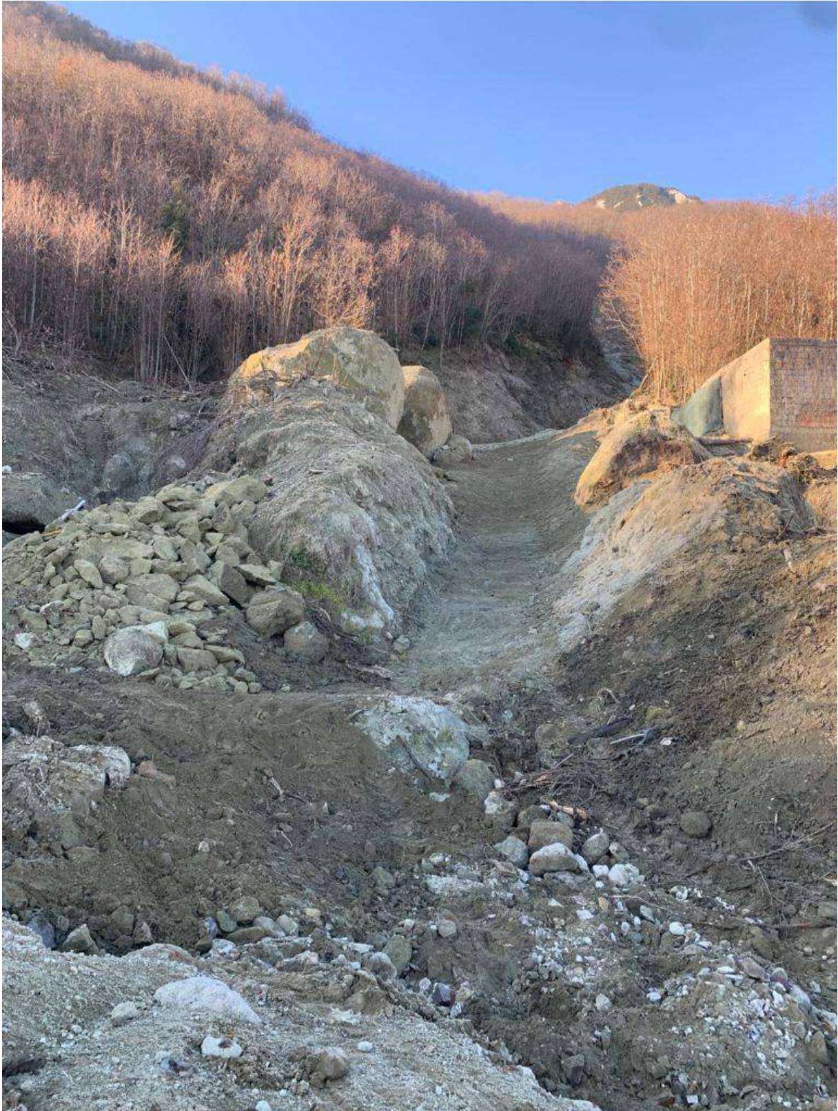
CE_ 5. Grossi massi depositati da eventi franosi passati e accumuli di materiale lapideo a valle. Zona di accumulo del Celario
