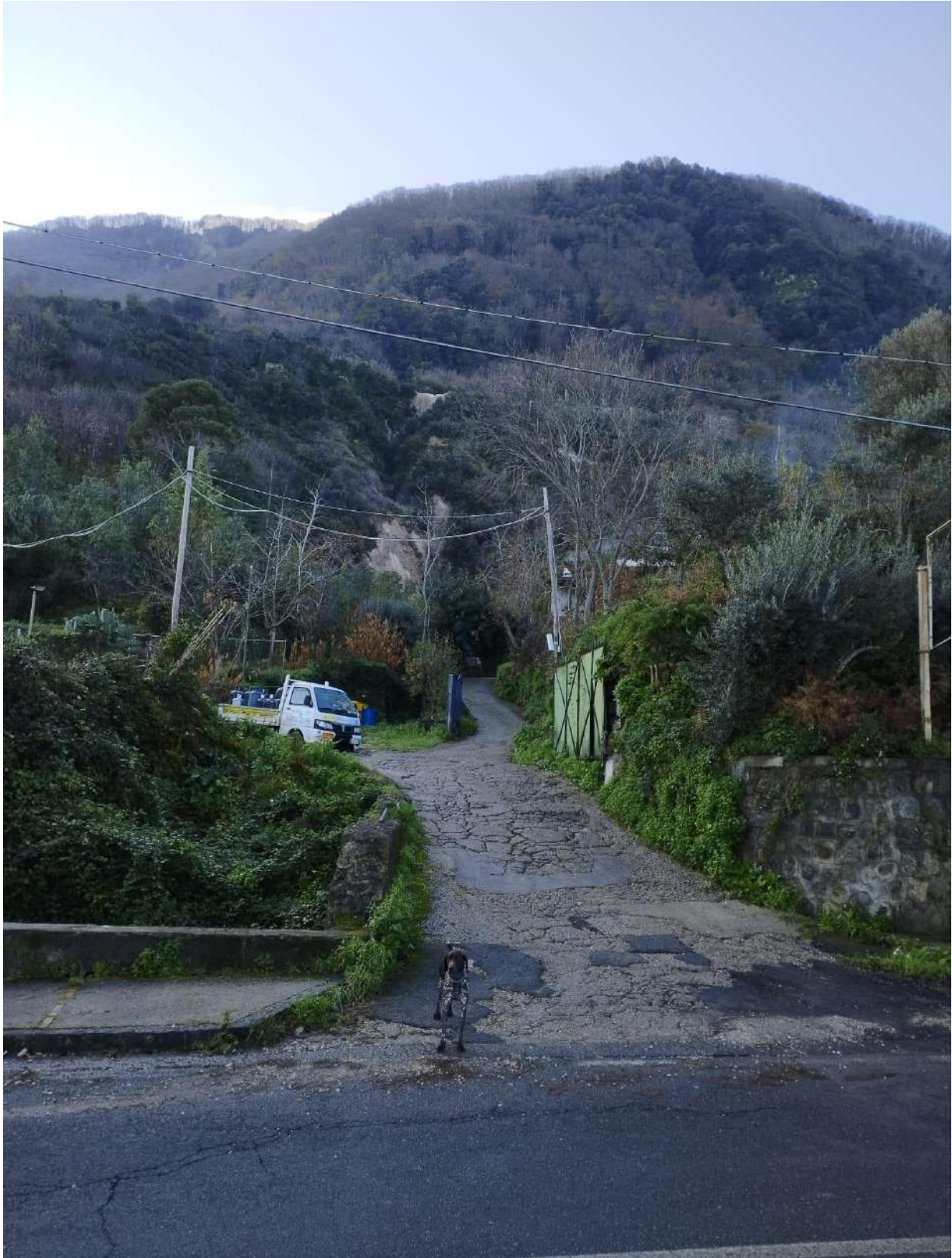
M_6_F. Tratto di attraversamento via Montecito mediante sottopasso posizionato sulla sinistra in corrispondenza del Marciapiede
