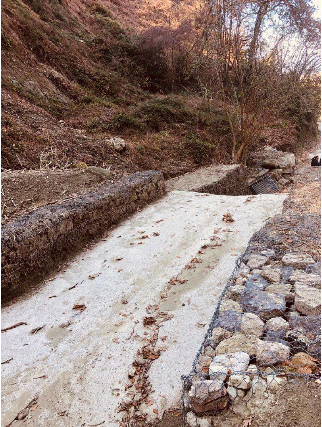
S_ 11_F. Intervento realizzato a seguito dell'evento del 26 novembre costituito da gabbionate metalliche per ripristinare la sezione dell'alveo.
