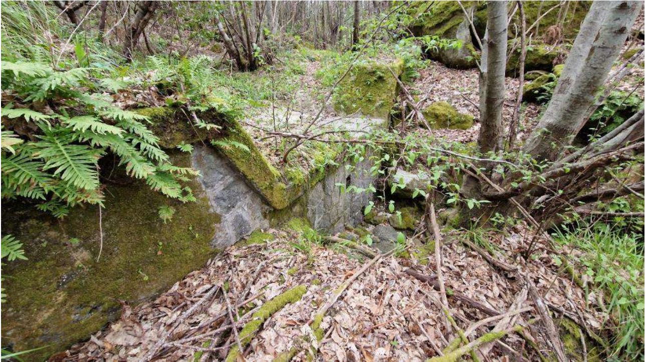
CU_10_F. Briglia anni '40 completamente ricoperta di materiale depositatosi negli anni
