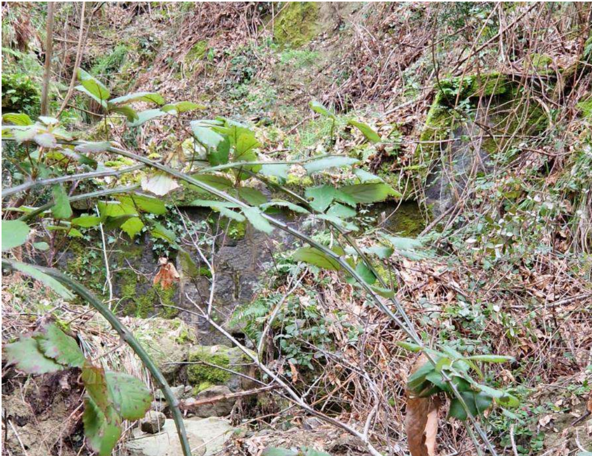
CU_13_F. Briglia anni 40 completamente ricoperta di materiale depositatosi negli anni
