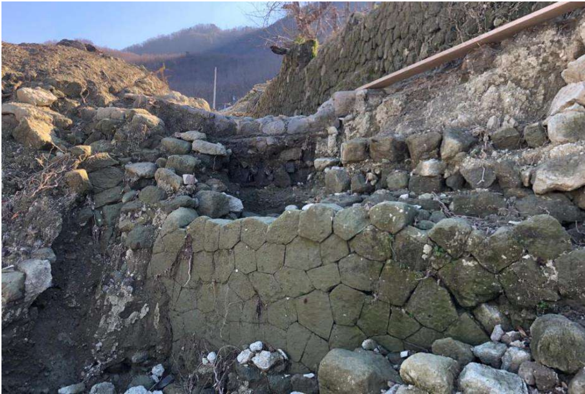
CE_ 8. Sistema di briglie realizzate negli anni '30 con blocchi lapidei squadrate. Parziale collasso delle opere
