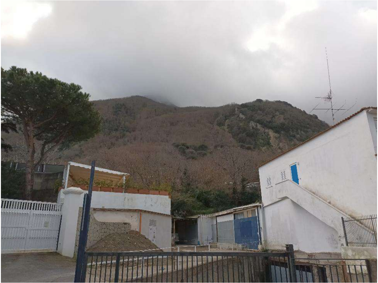
MO_5_F. deposito realizzato in corrispondenza dell'alveo
