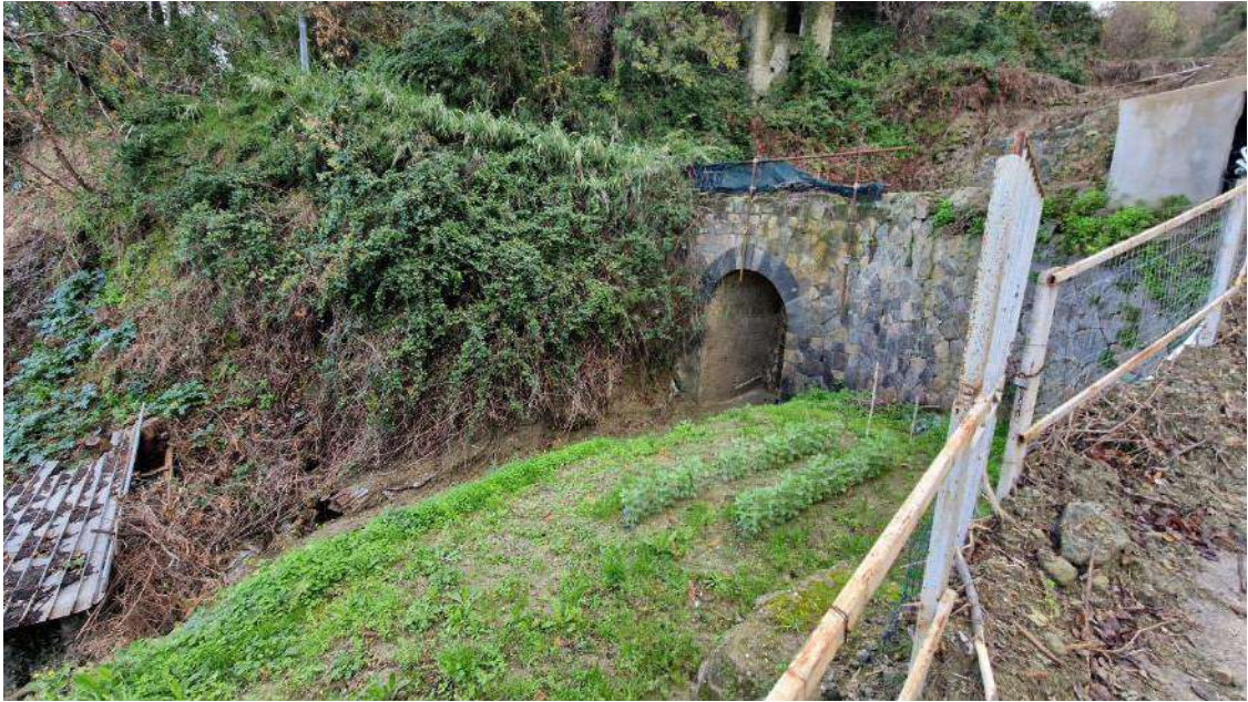
N_6_F. La foto evidenzia la presenza di un ponticello parzialmente crollato a valle della briglia. Materiale di accumulo di varia natura a valle.
