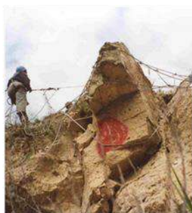
Figura 7.1 - Demolizione con esplosivi chimici espansivi (in alto) e imbragaggio massi isolati (in basso).
