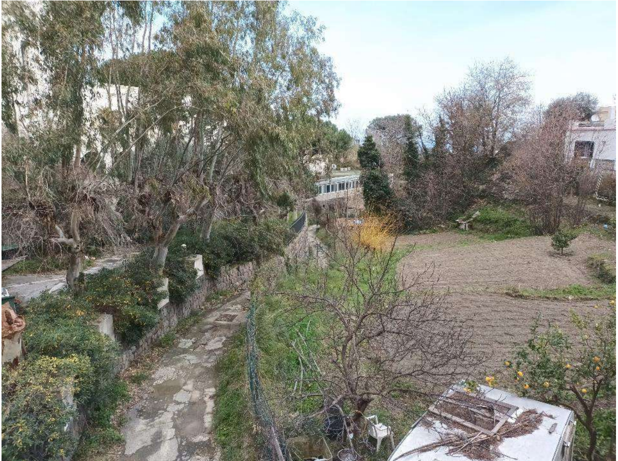
MO_7_F. tratto post attraversamento stradale, l'alveo presenta tratti asfaltati
