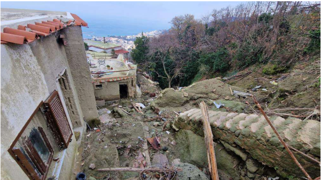
FO_1_F. Tratto immediatamente a valle di via Celario che collega l'alveo Celario con l'alveo Fontana in corrispondenza di un forte salto idraulico. Il tratto è stato urbanizzato nel corso del tempo così che la strada, gli edifici e le ampie superfici impermeabili hanno alterato il naturale afflusso delle acque.
