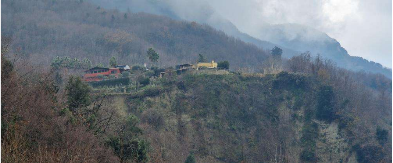
F_2_F. Costruzioni poste in corrispondenza del pendio fortemente acclive che ha subito importanti fenomeni di scivolamento della corte superficiale. L'intervento di messa in sicurezza del pendio dovrà tenere conto anche dei profili di legittimità delle costruzioni.
