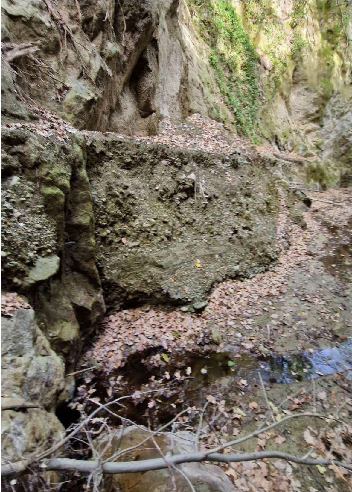
F_12_F. Materiale depositato per un'altezza di circa 3 m sul fondo dell'alveo e non trasportato a valle a seguito dell'evento del 26 novembre.
