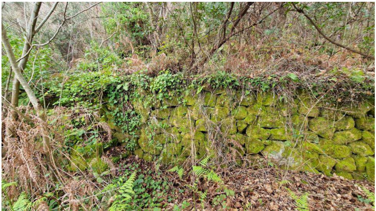
CU_3_F. . Muri di sostegno in pietra presenti lungo tutto il versante
