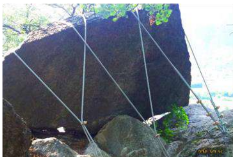
Figura 7.1 - Demolizione con esplosivi chimici espansivi (in alto) e imbragaggio massi isolati (in basso).
