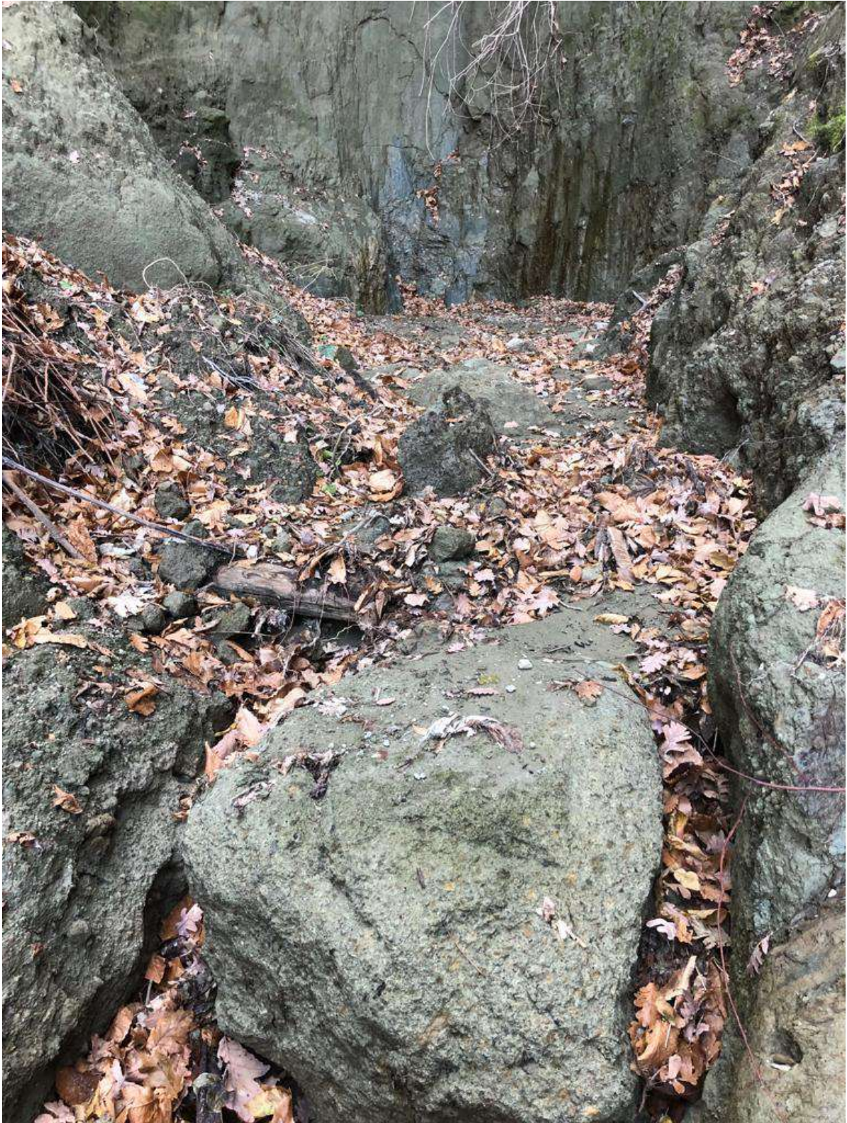
S_10_F. Fondo dell'alveo con deposito di massi di tufo di grosse dimensioni.
