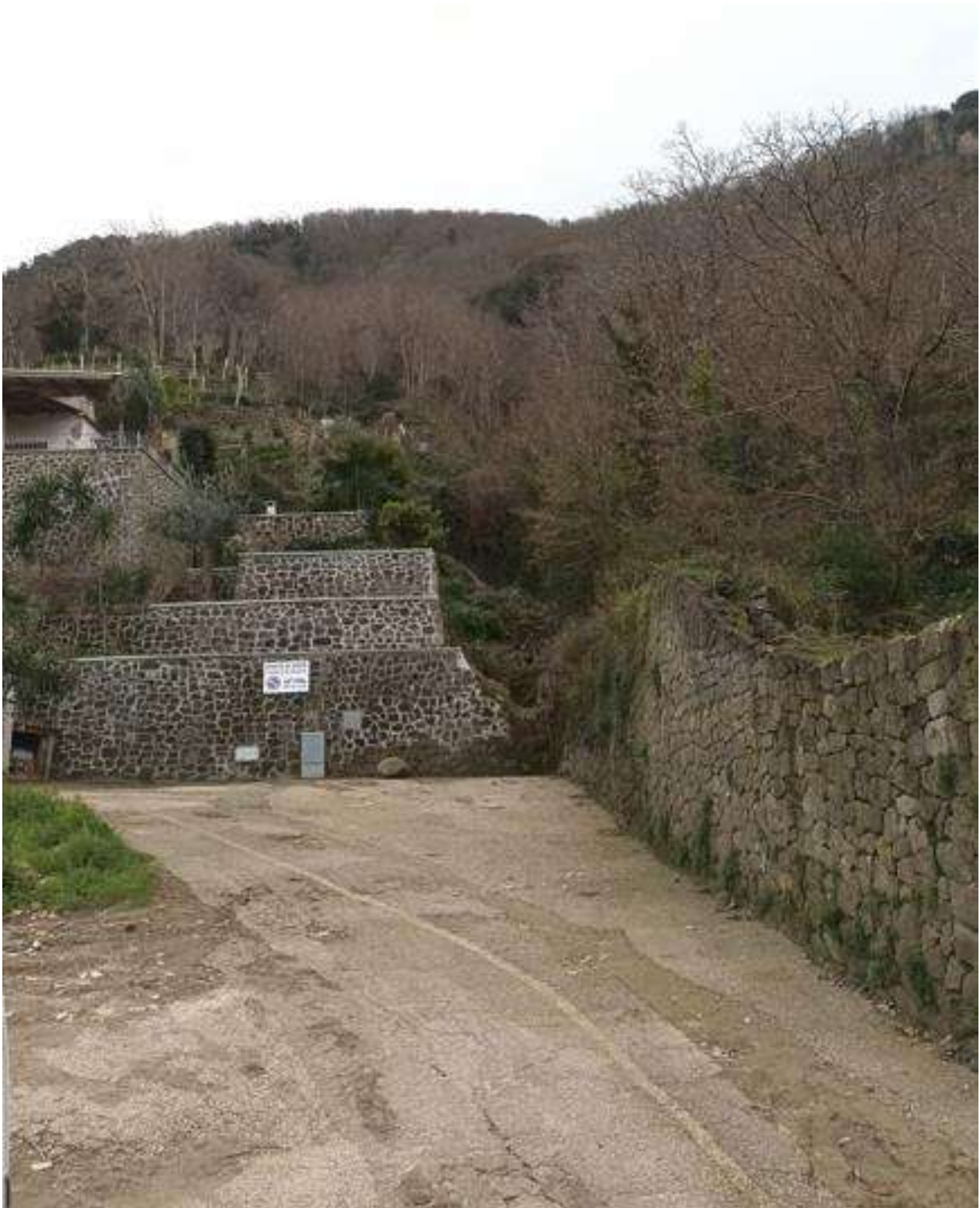
MO_1_F. Sistema di briglie realizzato intorno agli anni 40, costruzione edificata sul bordo laterale dell'alveo. Subito dopo le briglie è presente un tratto dell'alveo cementato utilizzato come strada di accesso alle abitazioni.
