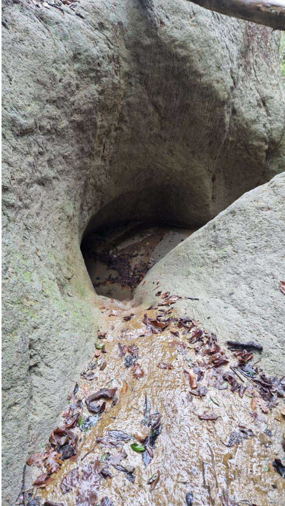
F_4_F. Fondo alveo in tubo scavato dall'azione erosiva dell'afflusso idraulico. È probabile l'alterazione della roccia da parte della componente idrotermale.
