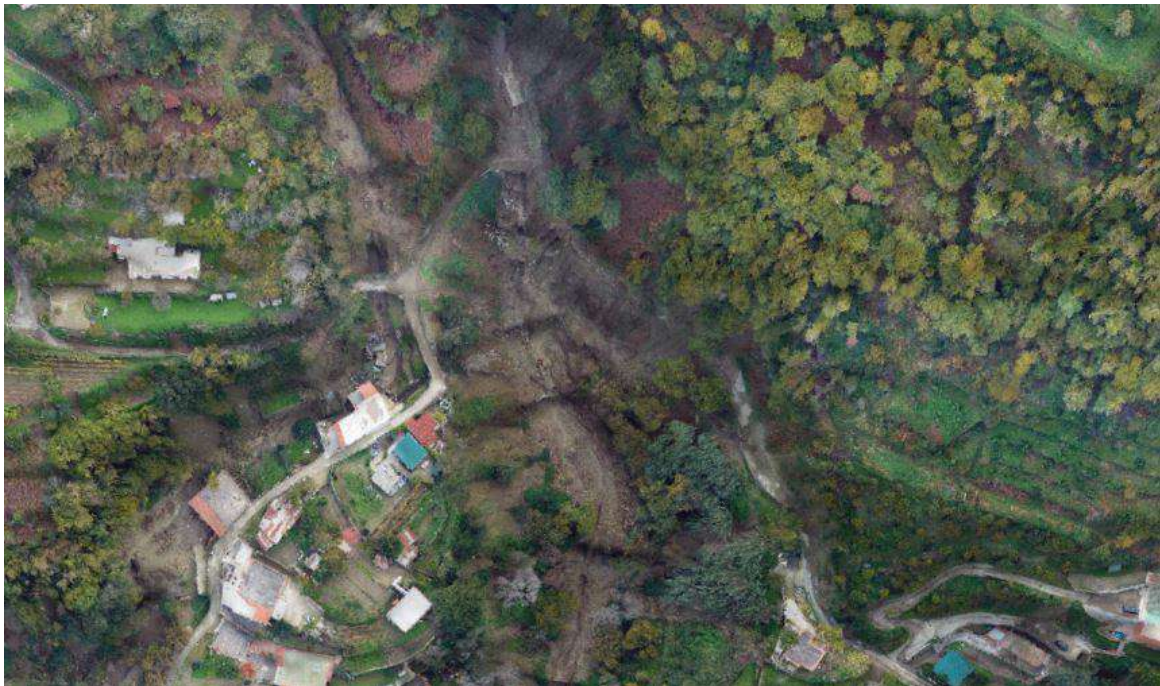
S_15_F. Serie di briglie realizzate negli anni '30 poste a valle della strada Il Traversa Santa Barbara. Forte accumulo di detriti sia a monte che a valle delle briglie che sono state portate alla luce grazie al forte fenomeno erosivo determinato dal flusso idrico del 26 novembre
