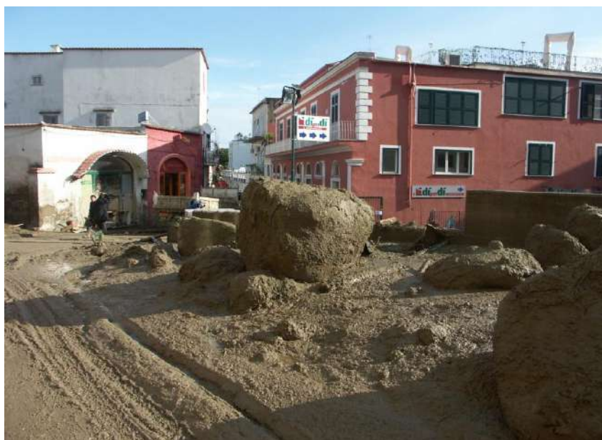
Figura 2.1.1 - Danni causati dall'evento alluvionale del 10 novembre 2009 (da Calcaterra et al., 2010).
