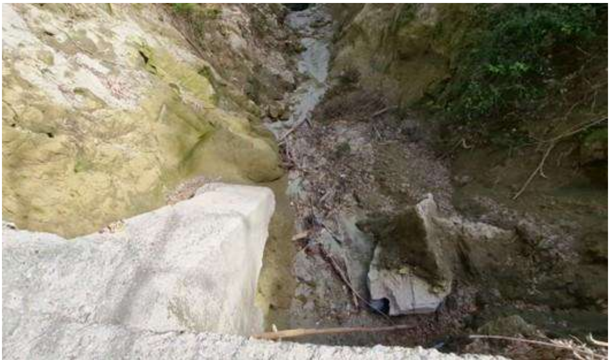
S_ 21_F. Grossa briglia in cemento armato di altezza circa 10 m realizzata a seguito dell'evento franoso del 2009 per stabilizzare il materiale di accumulo fondo alveo
