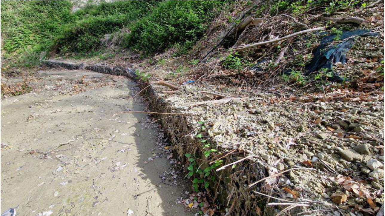
F_17_F. Gabbionate metalliche realizzate in seguito all'evento 2009 a protezione delle pareti erose. Si presuppone che l'intervento sia stato progettato ed eseguito con lo stesso approccio di mitigazione del rischio idraulico ci quello dell'alveo Puzillo e presenta i gabbioni anche sul fondo
