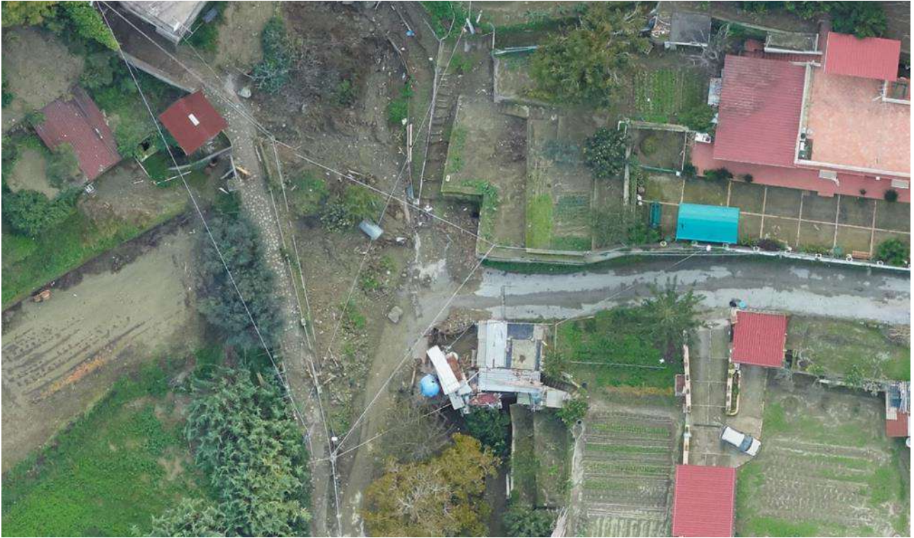
CU_16_F. intersezione Alveo con strada di accesso abitazioni
