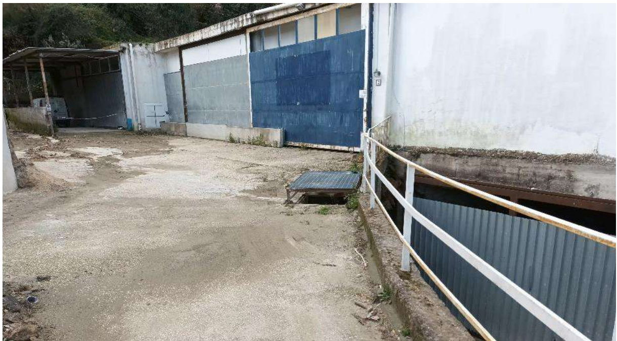
MO_3_F. Immissione tratto tombato in corrispondenza deposito realizzato in corrispondenza dell'alveo
