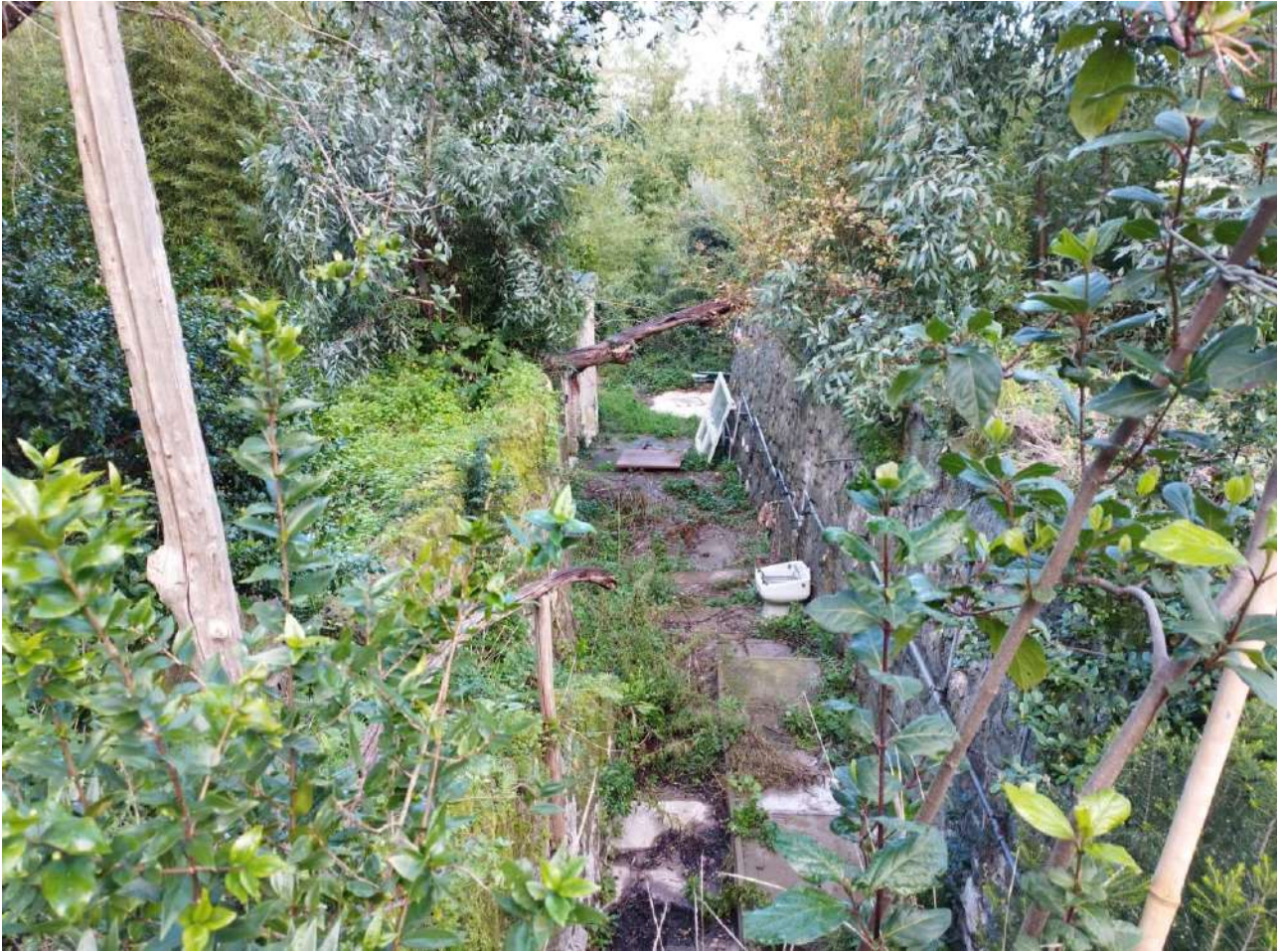
M_5_F. fondo alveo antropizzato con materiale di accumulo e vegetazione
