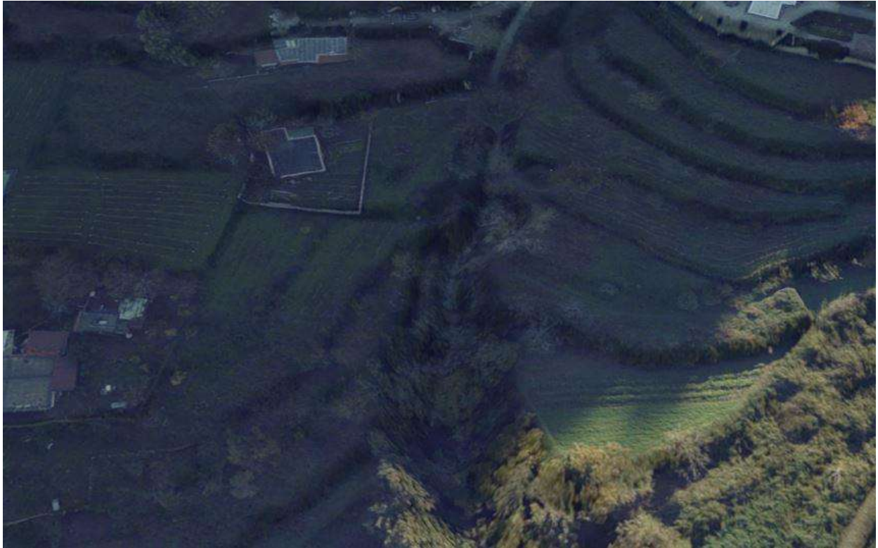
MO_2_F. Termine tratto cementato con tratto ad alveo naturale
