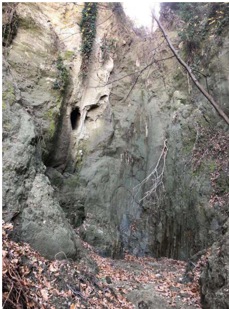
S_9_F. Salto idraulico naturale con restringimento della sezione dell'alveo. La forte erosione ha portato a vista il substrato roccioso lungo le pareti laterali dell'alveo
