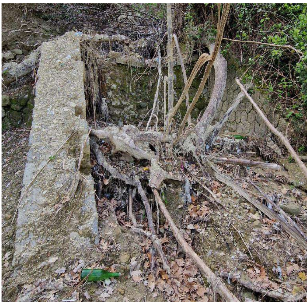
N_ 16_F. Prima di una serie composta da tre briglie in muratura realizzata negli anni '30; altezza di circa 3 m.
