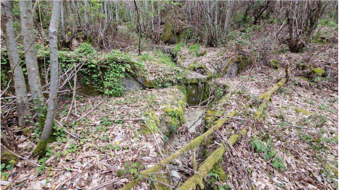
CU_8_F. Briglia anni 40 completamente ricoperta di materiale depositatosi negli anni
