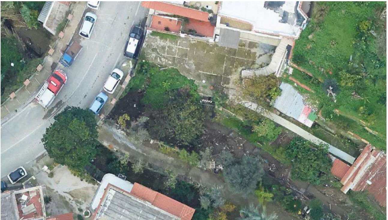
CU_17_F. Ponte borbonico su via montecito
