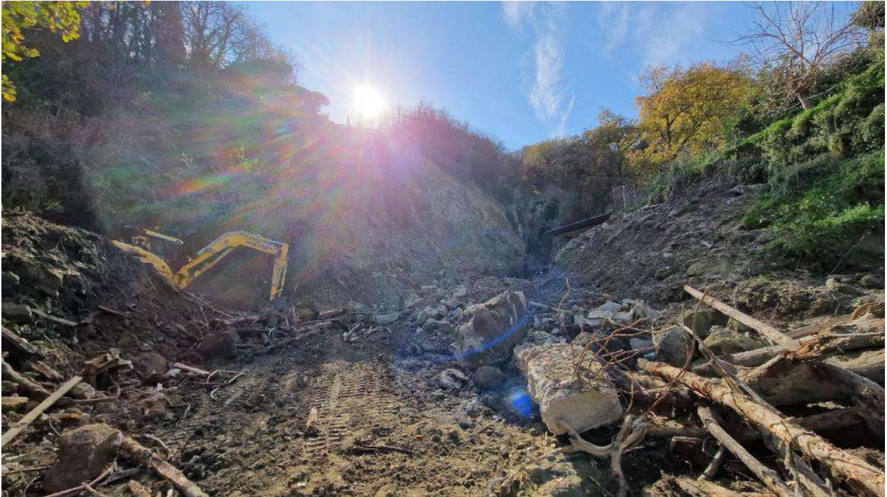
FO_4_F. Materiale di accumulo su fondo dell'alveo caratterizzato sia da materiale naturale che da materiale di risulta proveniente da edifici distrutti
