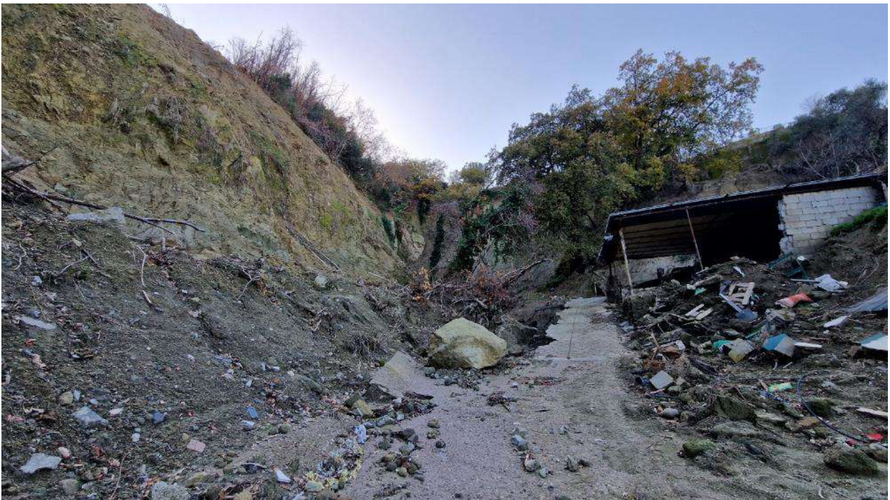
FO_3_F. Rudere realizzato sul bordo dell'alveo con strada in cemento armato realizzata sul fondo dell'alveo
