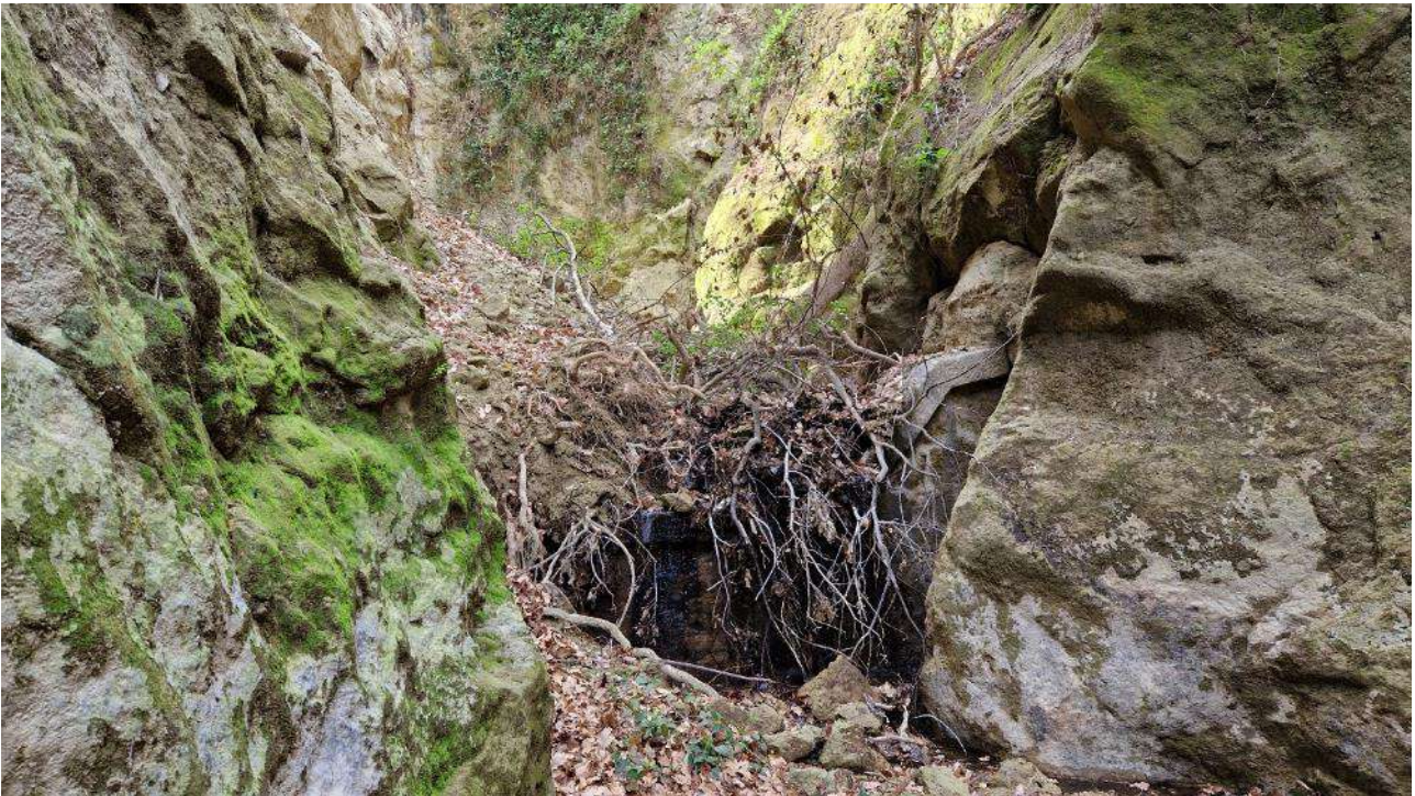
F_ 15_F. Briglia presumibilmente realizzata nel corso degli interventi realizzati a seguito dell'alluvione del 1910 (anni '30). Si nota il forte accumulo di detriti sulla gaveta e l'ulteriore apporto di materiale dalle sponde acclivi.
