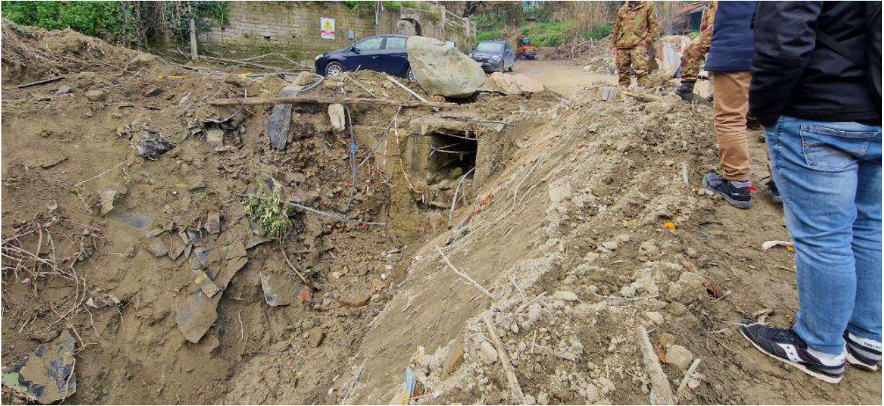
FO_8_F. tubazione di immissione acque piovane raccolte da Via Santa Barbara e immesse nell'alveo Fontana
