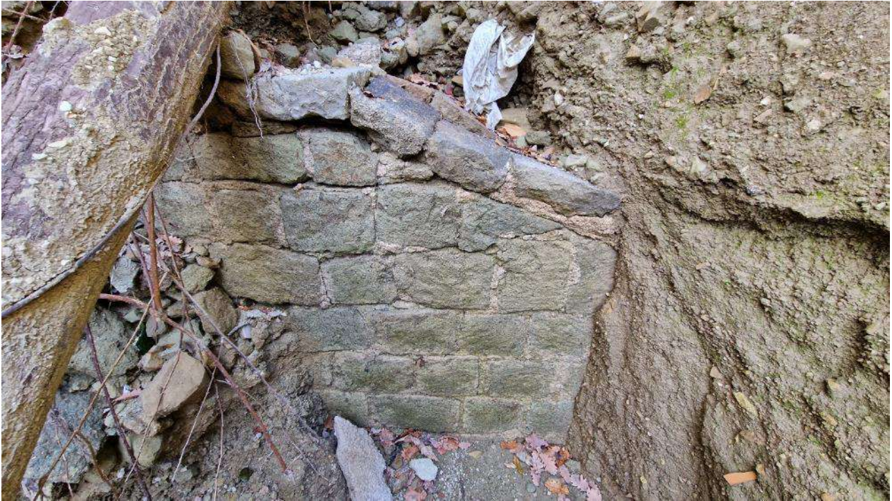
N_11_F. Briglia in tufo verde parzialmente ricoperta da terreno proveniente da scorrimento superficiale da versante laterale. È evidente che lo stato complessivo delle briglie necessita di un generale intervento di messa in pristino.
