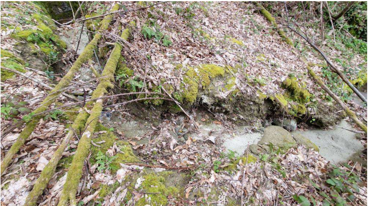
CU_9_F. Azione erosiva dell'evento meteorico del 2022 del materiale depositato sul fondo dell'alveo
