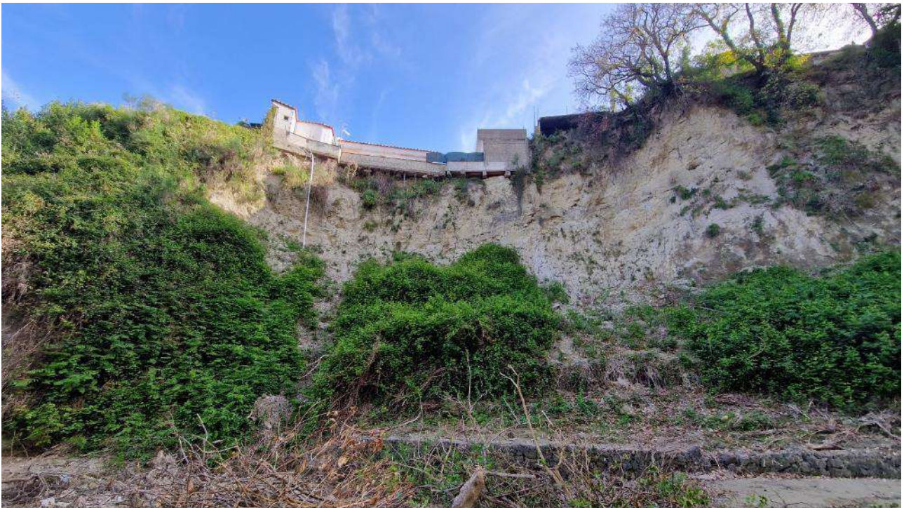
F_18_F. Edifici costruiti in corrispondenza del ciglio del pendio. La presenza di vegetazione soprattutto nella zona sommitale mette in luce che il versante non sia stato oggetto, di recente, di fenomeni di scivolamento della coltre superficiale senza poter tuttavia escludere che si siano verificati crolli o discoscimenti di limitate dimensioni in ristrette aree del versante durante l'evento del 26 novembre
