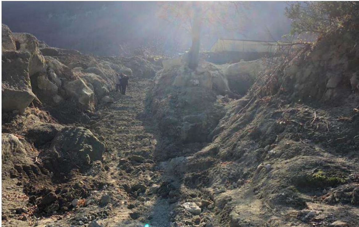
CE_ 9_F. Alveo provvisorio realizzato a seguito dell'evento per la regimentazione delle acque piovane
