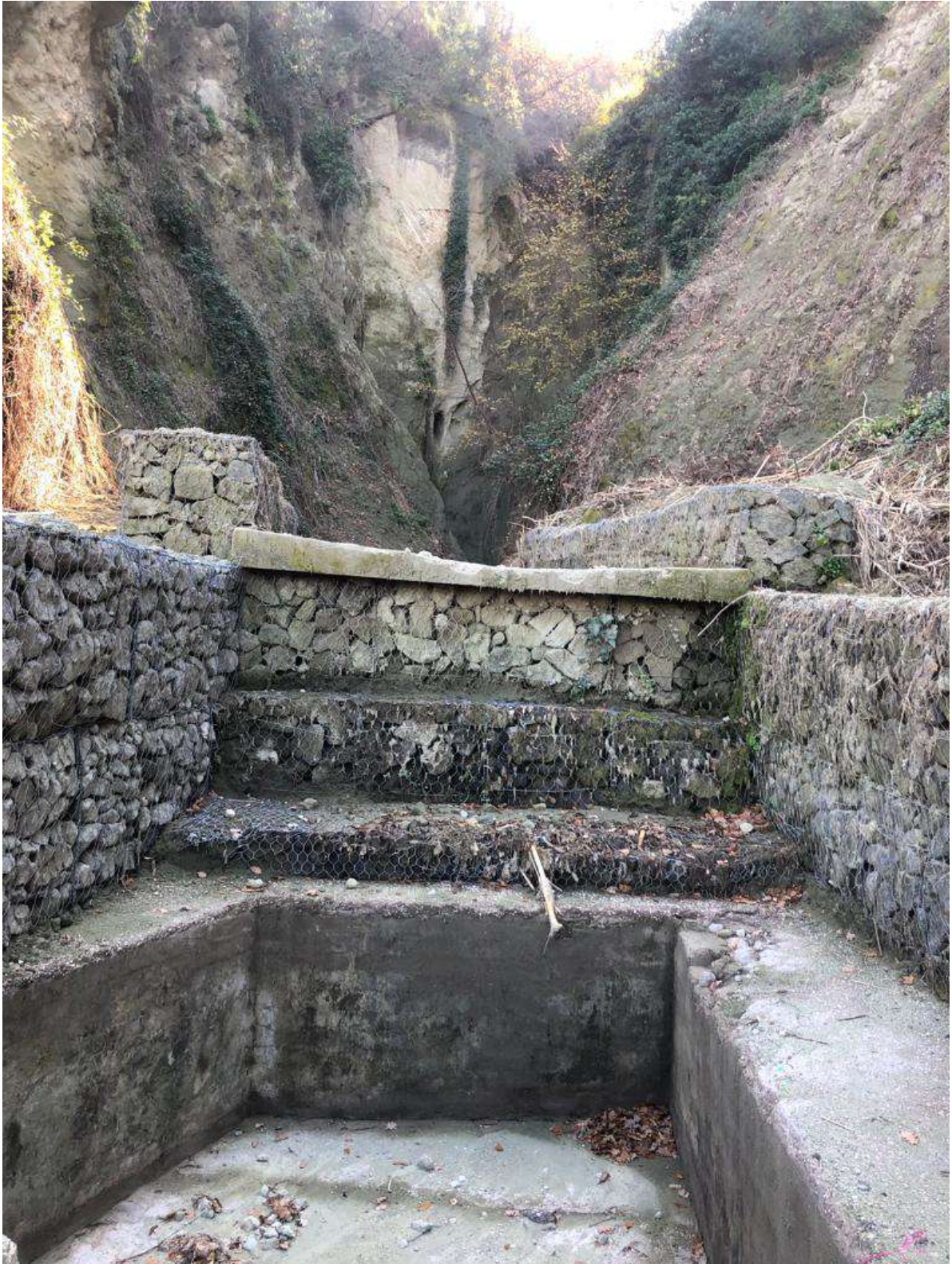
S_ 13_F. Vasca realizzata per il deflusso delle acque al di sotto della strada
