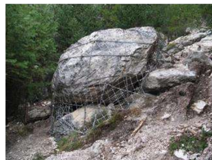
Figura 7.1 - Demolizione con esplosivi chimici espansivi (in alto) e imbragaggio massi isolati (in basso).
