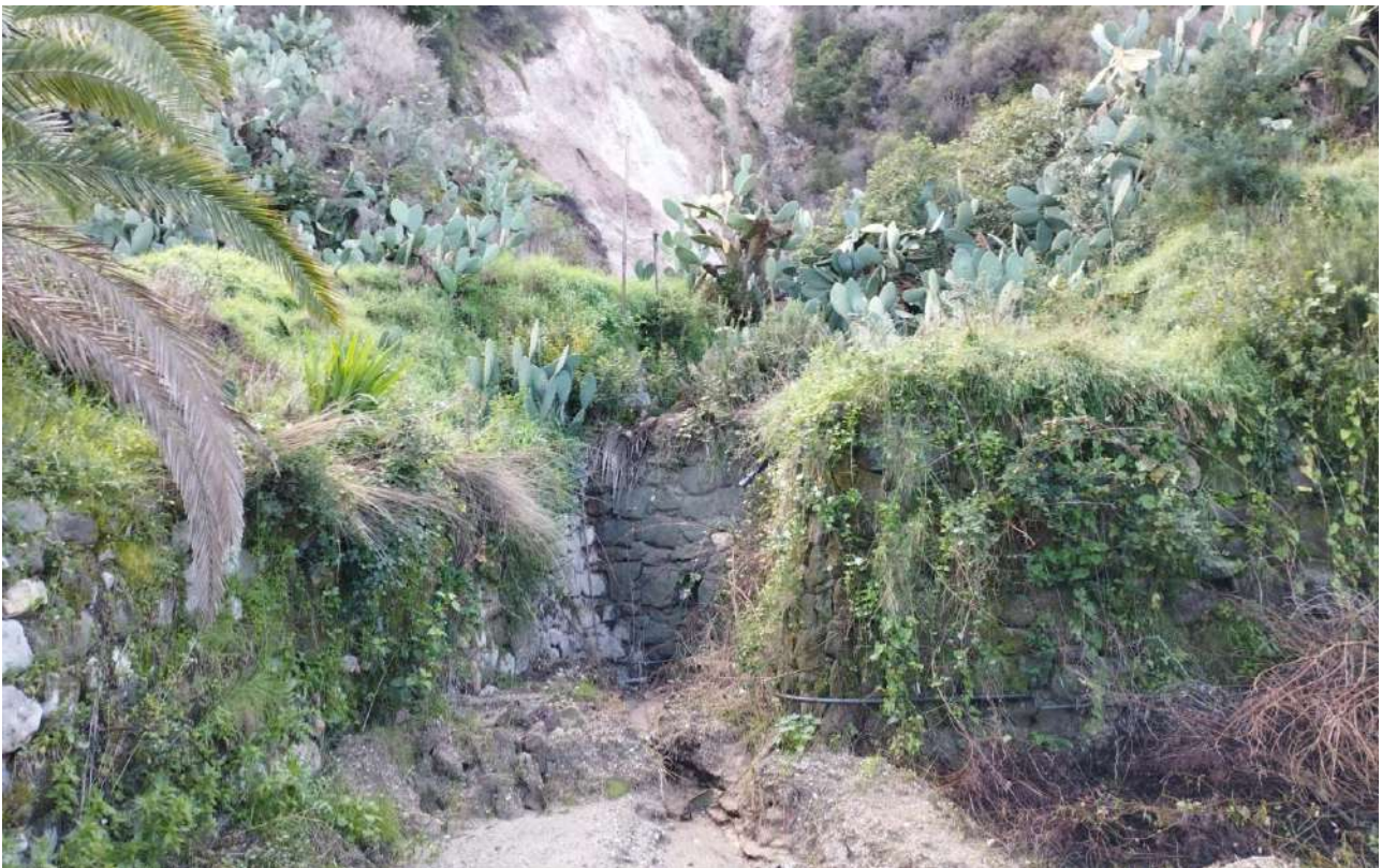
M_4_F. Vecchia briglia in muratura di tufo verde ischitano
