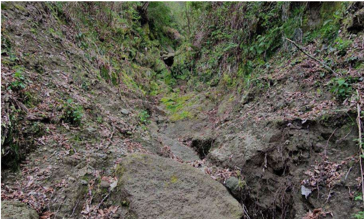
S_3_F. Fondo dell'alveo a monte in corrispondenza della zona boschiva, materiale di accumulo sul fondo proveniente da scorrimento superficiale
