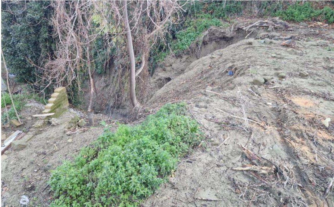
N_ 9_F. Materiale detritico accumulato a valle dell'abitazione mostrata nella foto precedente, tramite palancolata costituita da tubi in acciaio e reti crollata a seguito dell'evento. Si nota la forte erosione avvenuta nel deposito probabilmente per effetto degli eventi meteorici successivi al 26 novembre 2022.
