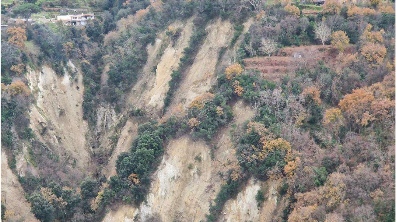
F_5_F. La foto mostra un notevole salto idraulico in corrispondenza dell'edificio di colore bianco. Procedendo verso valle le pareti acclivi dell'alveo sono caratterizzate da fenomeni di scorrimento superficiale diffusi e conseguenti importanti depositi nel fondo.
