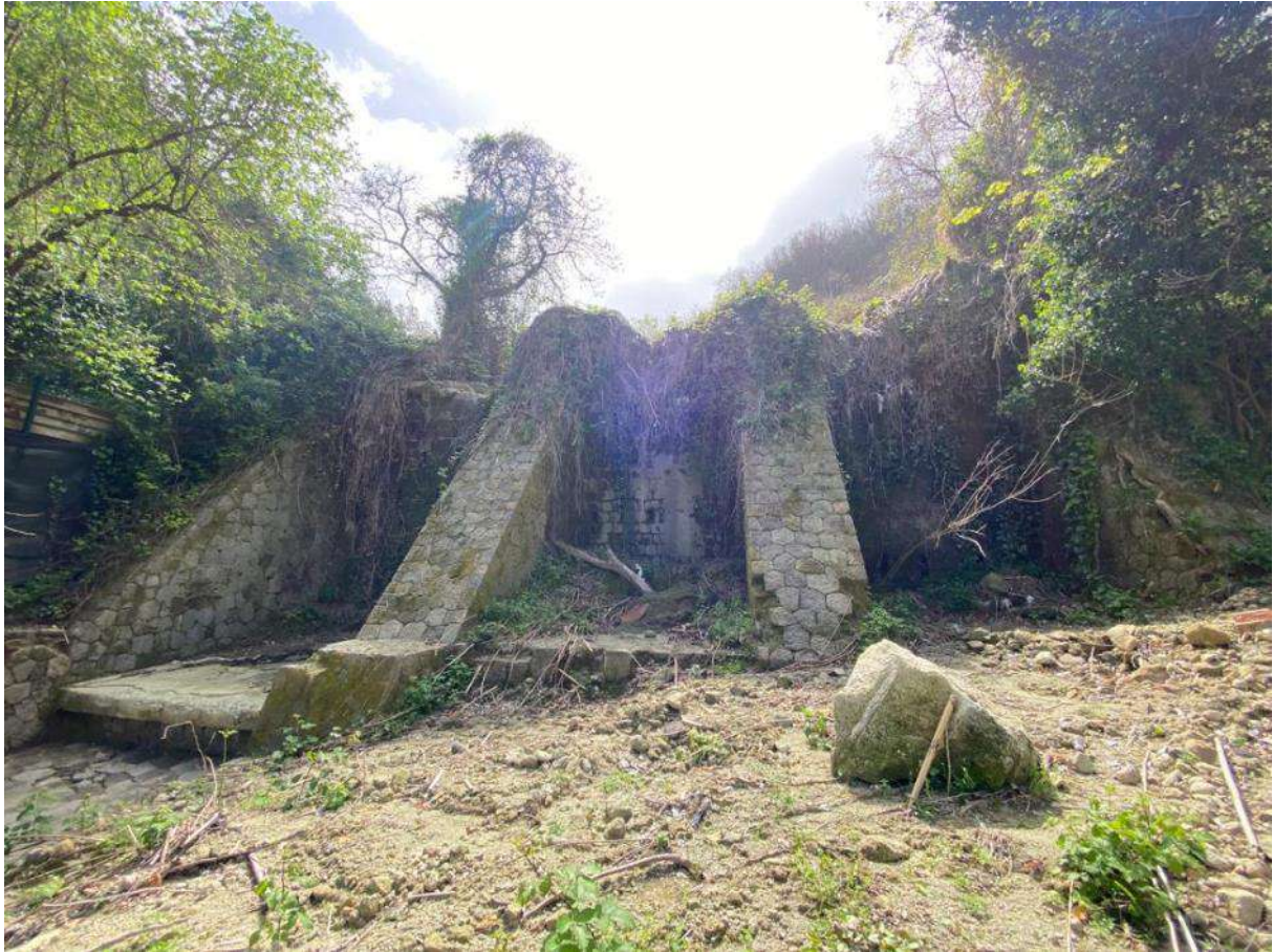
S_ 18_F. Grossa briglia o diga di altezza 10m e larghezza 25 con contrafforti in muratura di spessore circa 1,5 m
