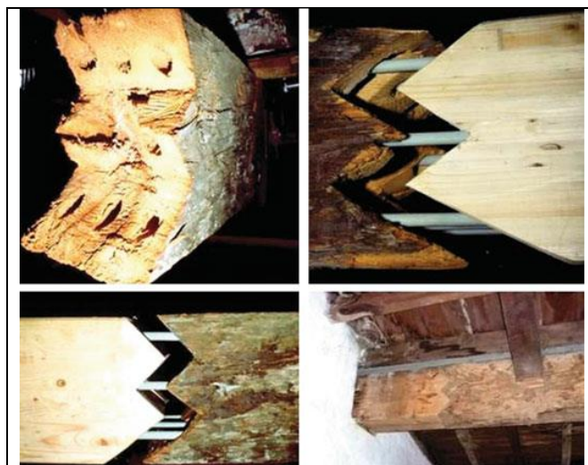
Fig.15 – Sostituzione di parti di elementi lignei ammalorati
