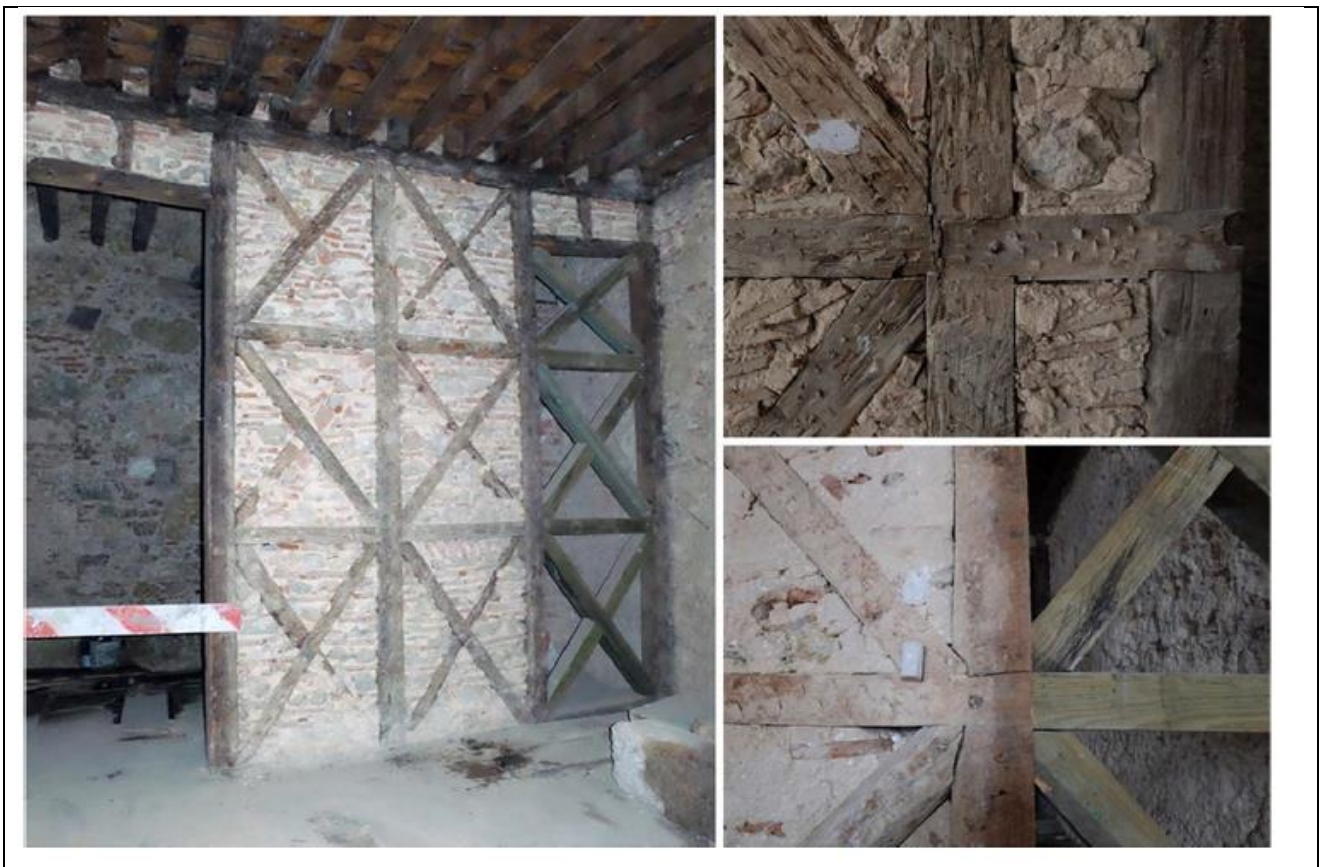
Fig. 7: Vista interna di un edificio pombalino in Rua dos Fanqueiros, Lisbona [4]
