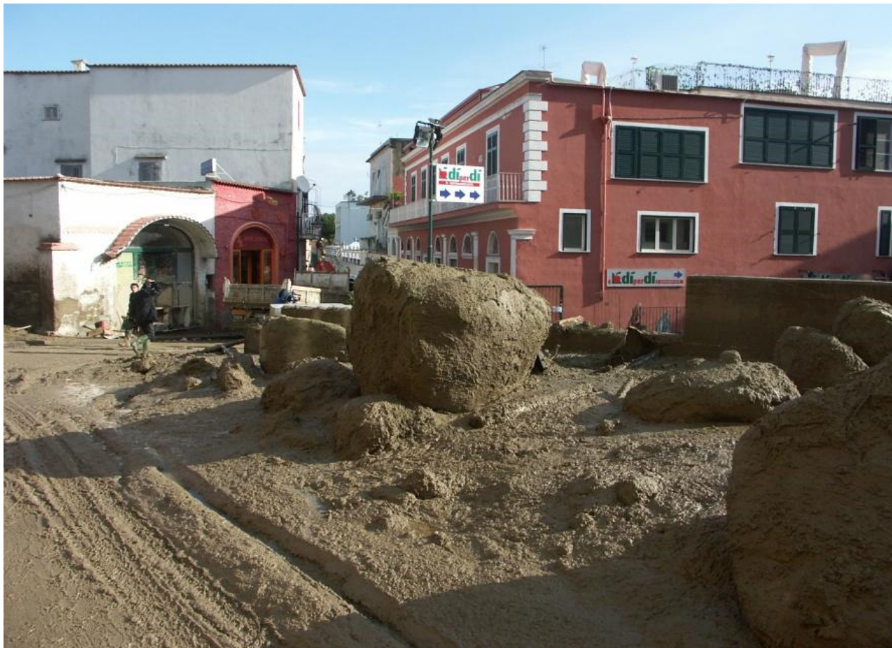
Figura 15. - Danni causati dall'evento alluvionale del 10 novembre 2009 (da Calcaterra et al., 2010).
