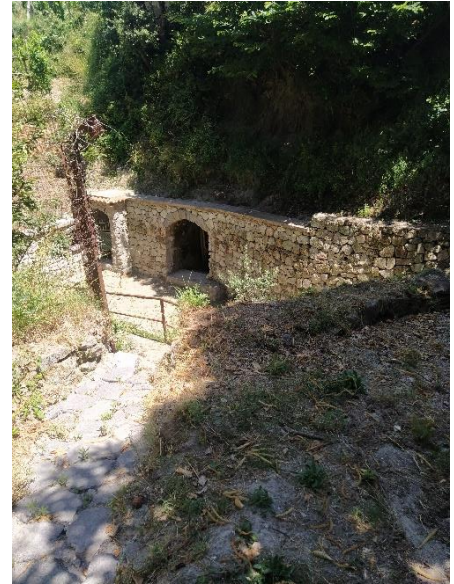
Figura I.4 parte terminale mulattiera in corrispondenza dell'intersezione con vallone
