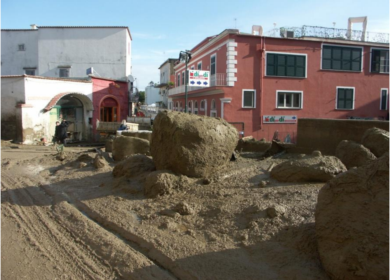
Figura 347. - Danni causati dall'evento alluvionale del 10 novembre 2009 (da Calcaterra et al., 2010).
