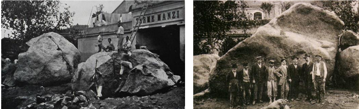
Figura 835 - Danni causati dall'evento alluvionale del 10 novembre 2009 ( https://www.isclano.com ).
