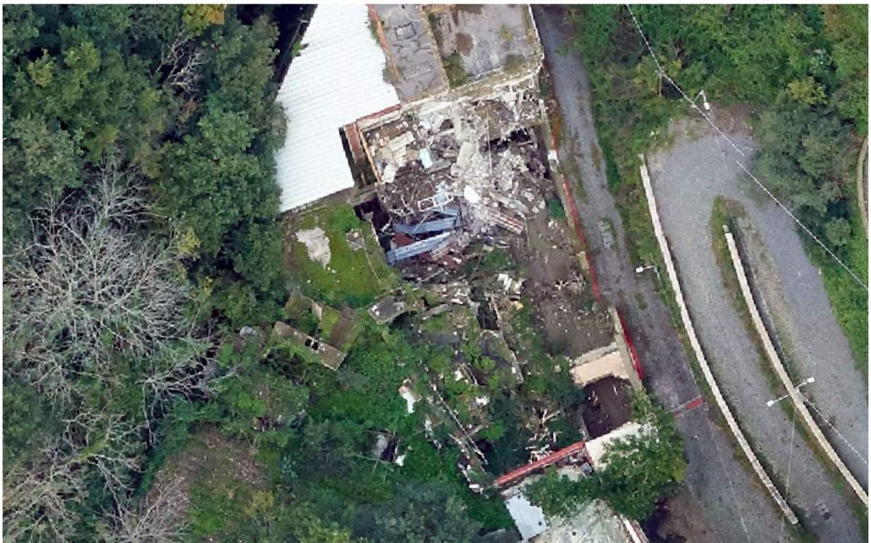
Figura 9. Rilievo fotografico dello stato di danno delle Terme La Rita
