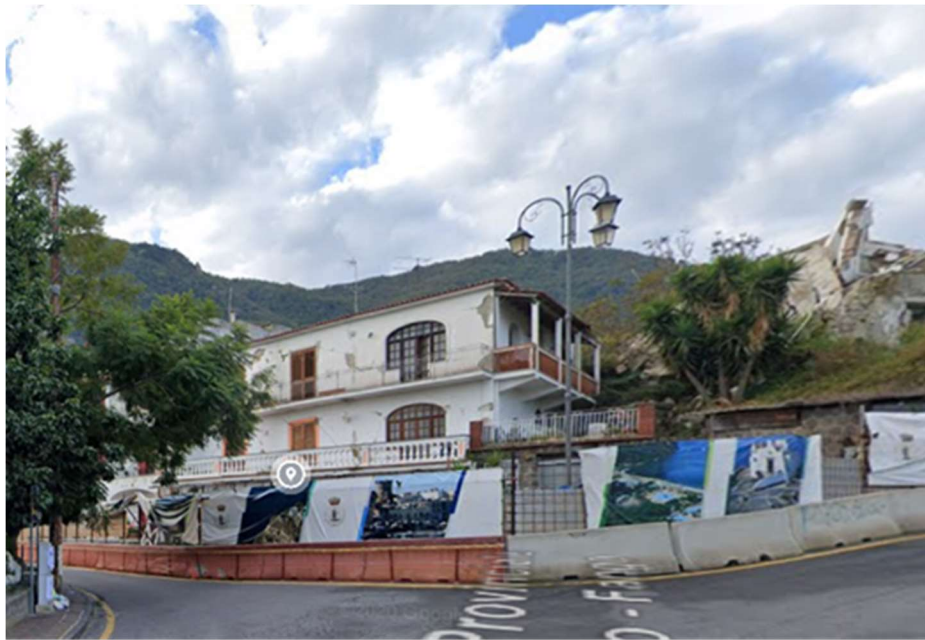
Figura 12. Edifici danneggiati – Località Fango
