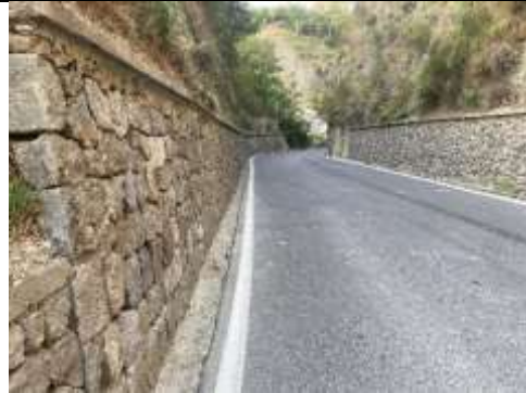
La struttura più tipica di Ischia contro i movimenti di massa sono i muri in pietra. Sia con materiale legante che non.
