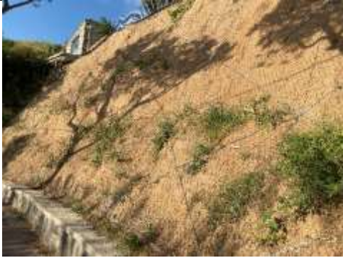
Reti in acciaio contro le frane con sotto un biotessuto (cocco o canapa) che permette la crescita di vegetazione.
