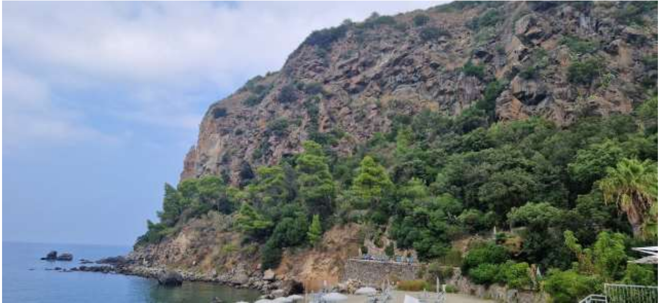
Figura 3-49. Località di Negombo con ubicazione della caduta massi e strutture chiuse (Google Earth).
