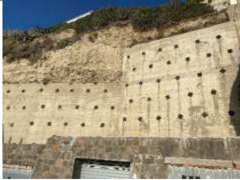
Alto muro di contenimento in cemento con ancoraggi contro le frane.
