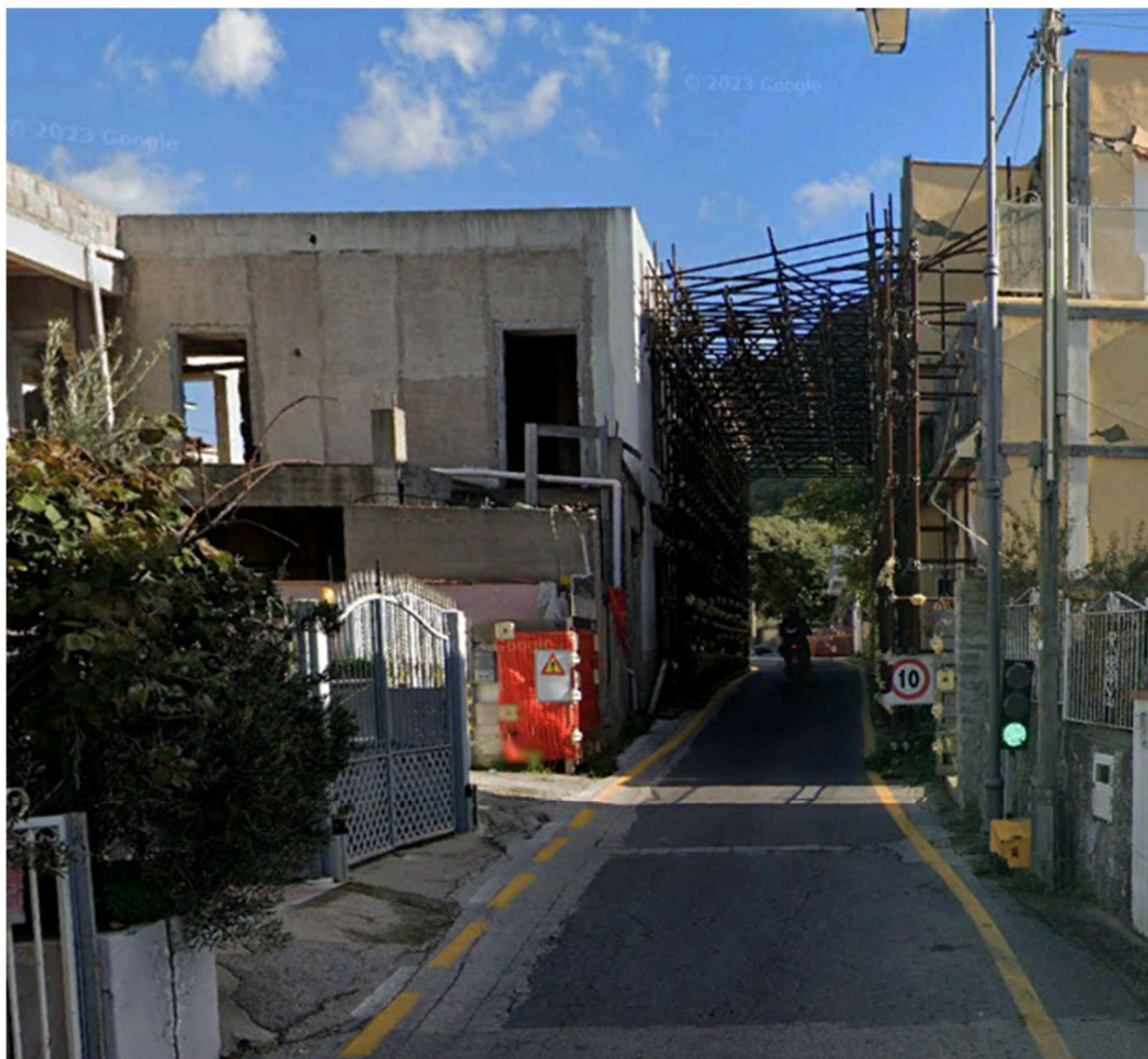
Figura 14. Restringimento della carreggiata – Località Fango
