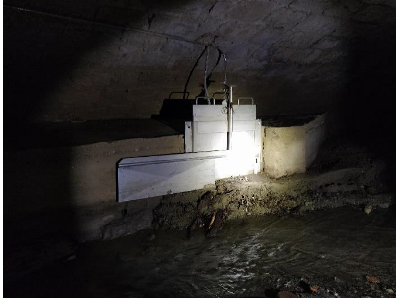
Figura 3. Paratoia a ghigliottina che viene tenuta aperta in tempo asciutto.
