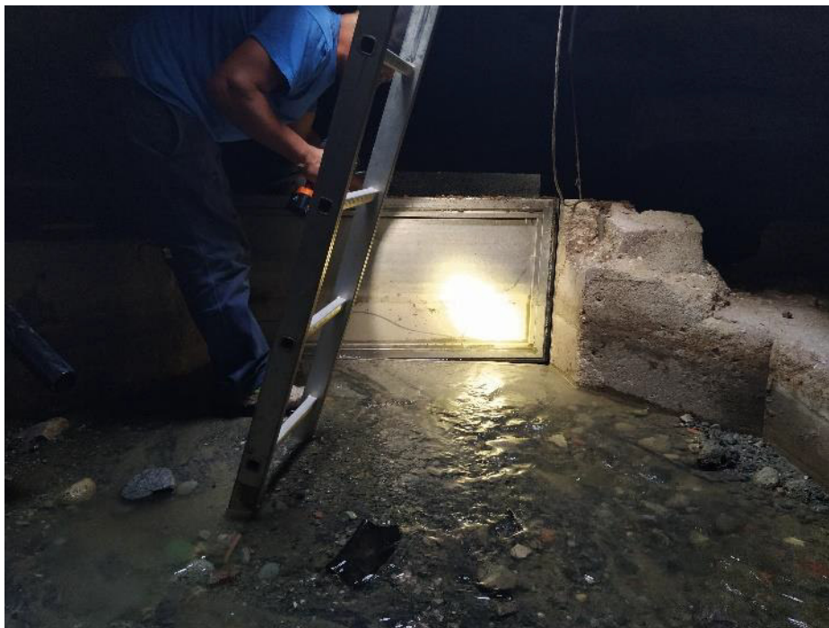
Figura 4. Immagine in prossimità della paratoia di 1,30m x 0,60m all'interno della "sezione di magra" delimitata da spallette in cls di altezza pari a 0,60m.
