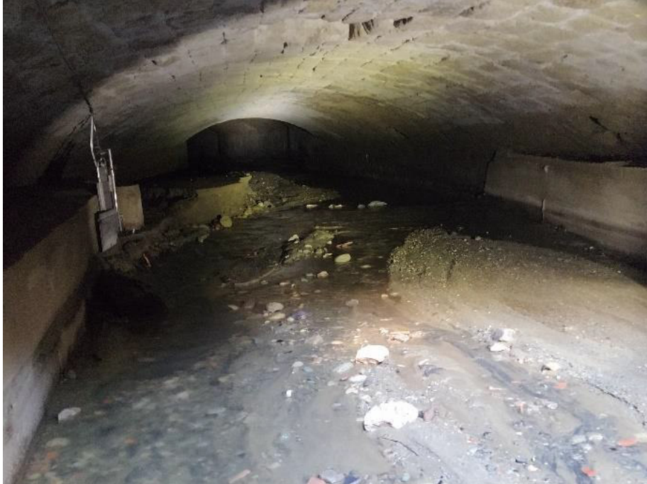
Figura 5. vista (in corrispondenza della paratoia di chiusura) da valle verso monte del canale di scarico, con in evidenza, in dx idraulica, della paratoia a ghigliottina per l'intercettazione delle portate in tempo asciutto.
