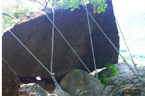
Figura 24- Demolizione con esplosivi chimici espansivi (in alto) e imbragaggio massi isolati (in basso).
