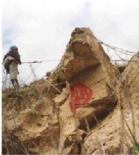
Figura 24- Demolizione con esplosivi chimici espansivi (in alto) e imbragaggio massi isolati (in basso).
