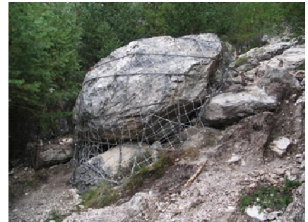
Figura 24- Demolizione con esplosivi chimici espansivi (in alto) e imbragaggio massi isolati (in basso).
