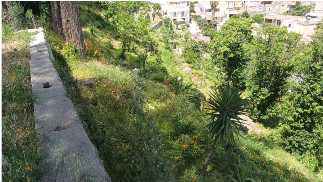
Figura 12. L'area dell'intervento IC07.12
