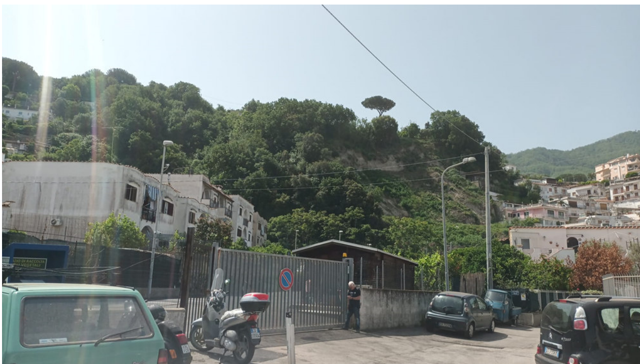
Figura 9. L'area dell'intervento IC07.4
