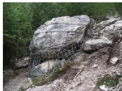
Figura 24- Demolizione con esplosivi chimici espansivi (in alto) e imbragaggio massi isolati (in basso).
