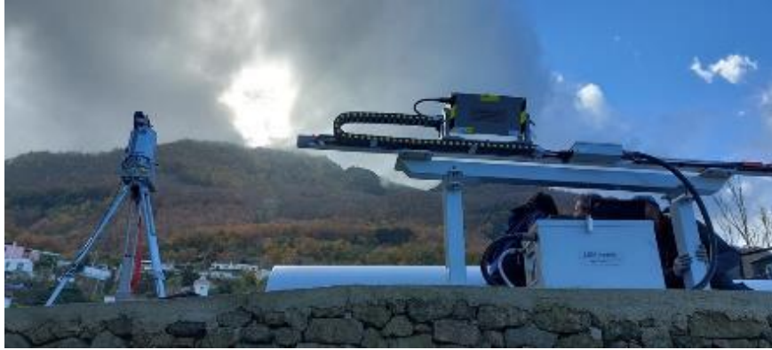
STAZIONE DI RILIEVO DEL FRONTE DI FRANA UNIFI
