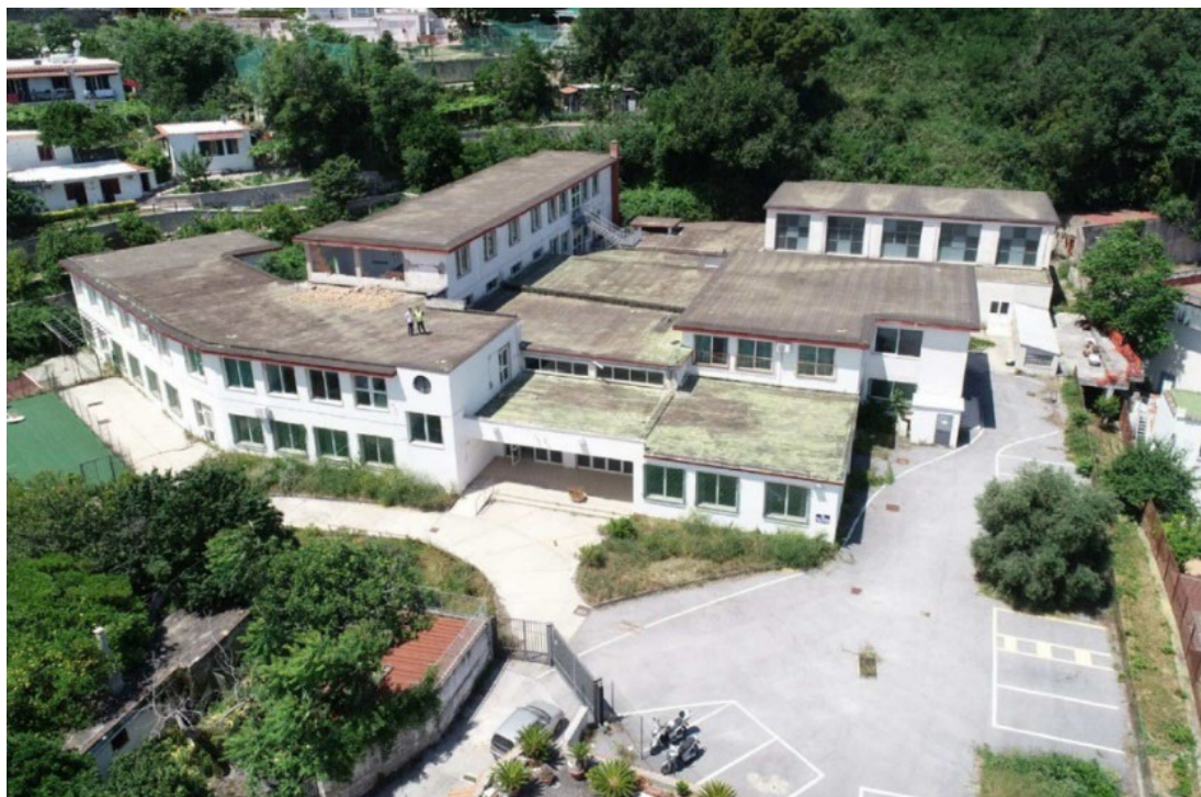
12 – Foto complesso scolastico Ibsen, stato attuale
