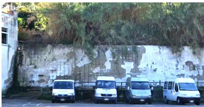
9 – Foto del muro di contenimento
